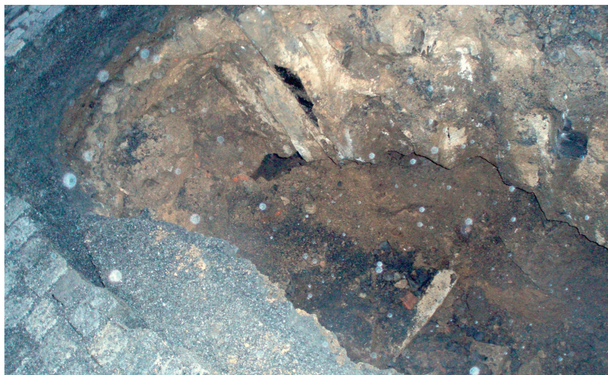
Odkrývání propadu, je vidět původní klenba
