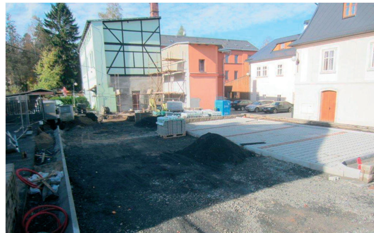
Stavba parkoviště na Pražské
